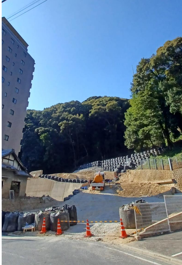
松山城土砂災害復旧現場
