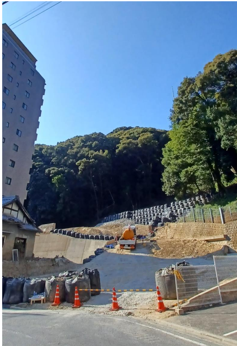
松山城土砂災害復旧現場
